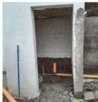
Foto 2: reparación de puerta principal
