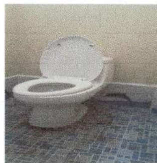
Foto 4: sustitución de inodoro
