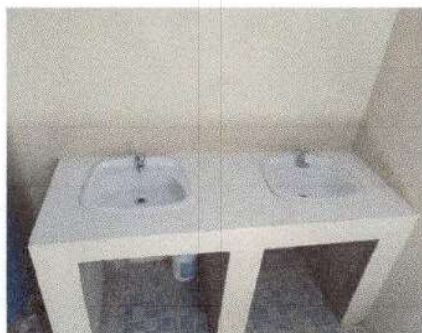
Foto 3: reparación de lavamanos
